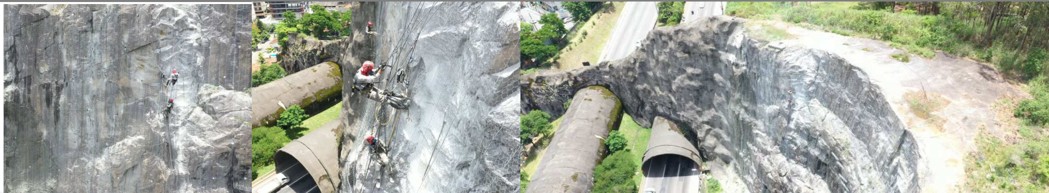
Linha Amarela S.A.- LAMSA - estabilização de talude em rocha no Emboque Norte do Túnel Enzo Totis.
