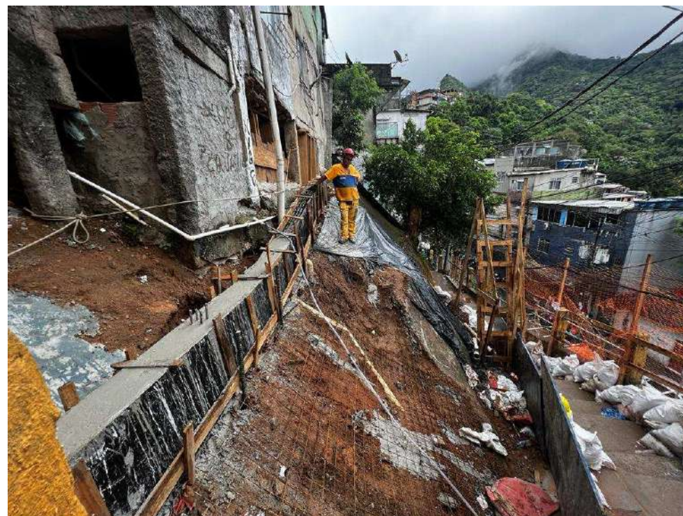
Execução de concreto projetado e da viga de topo
