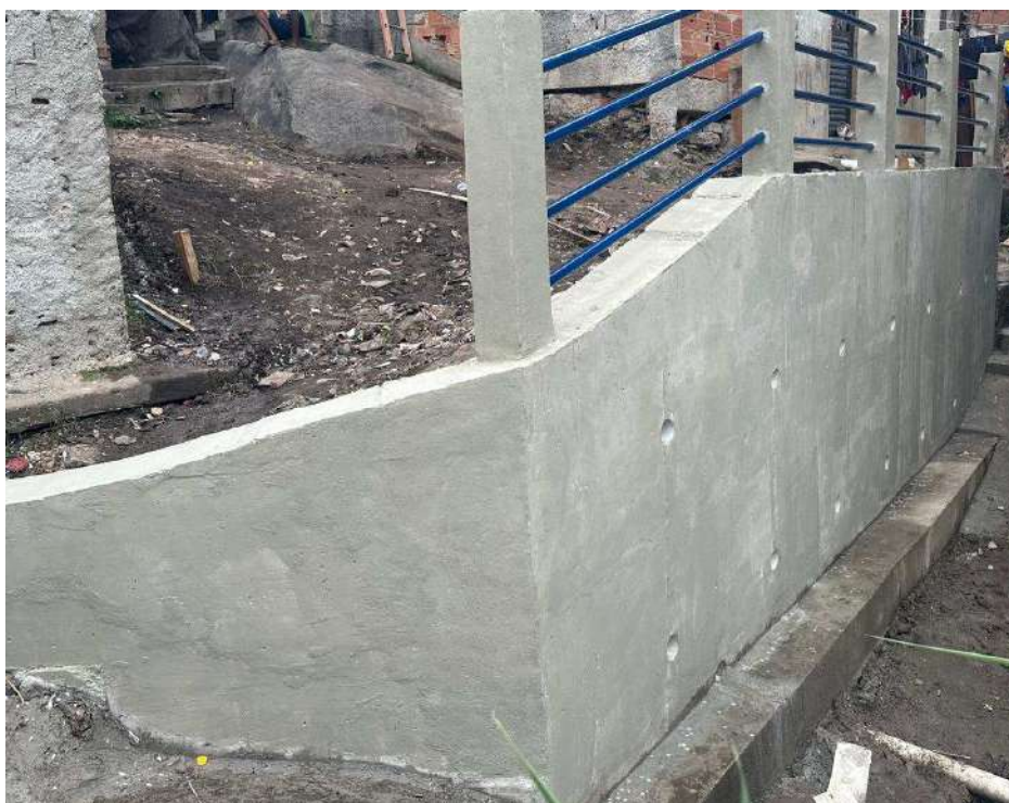
Muro estaqueado com guarda-corpo
