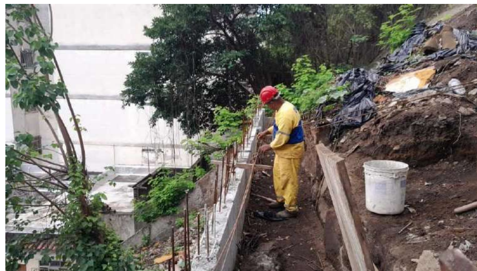
Recuperação de canaleta
