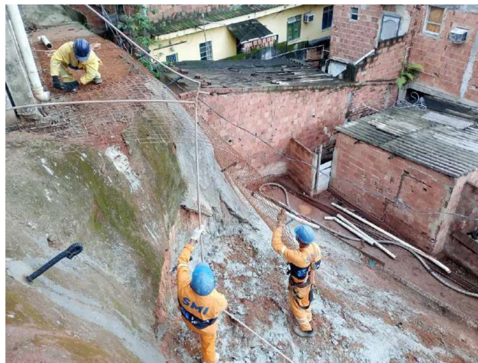
Colocação de Tela de aço soldada Telcon
