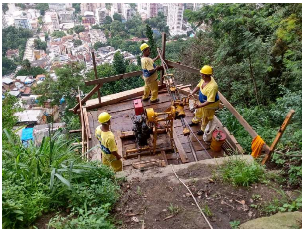
Perfuração dos tirantes dos contrafortes
