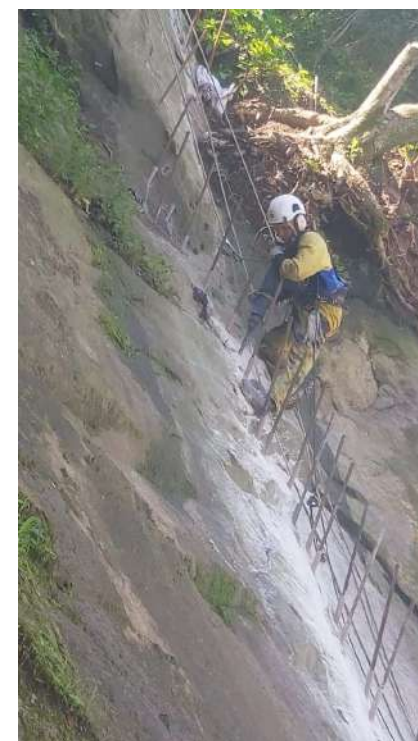
Perfuração dos chumbadores da viga
