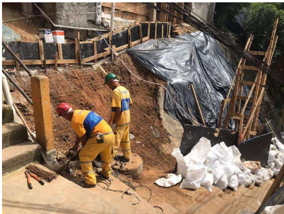
Execução de concreto projetado e da viga de topo
