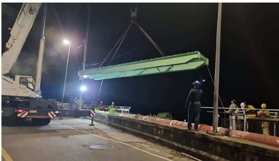
Colocação da estrutura metálica do vão 133
