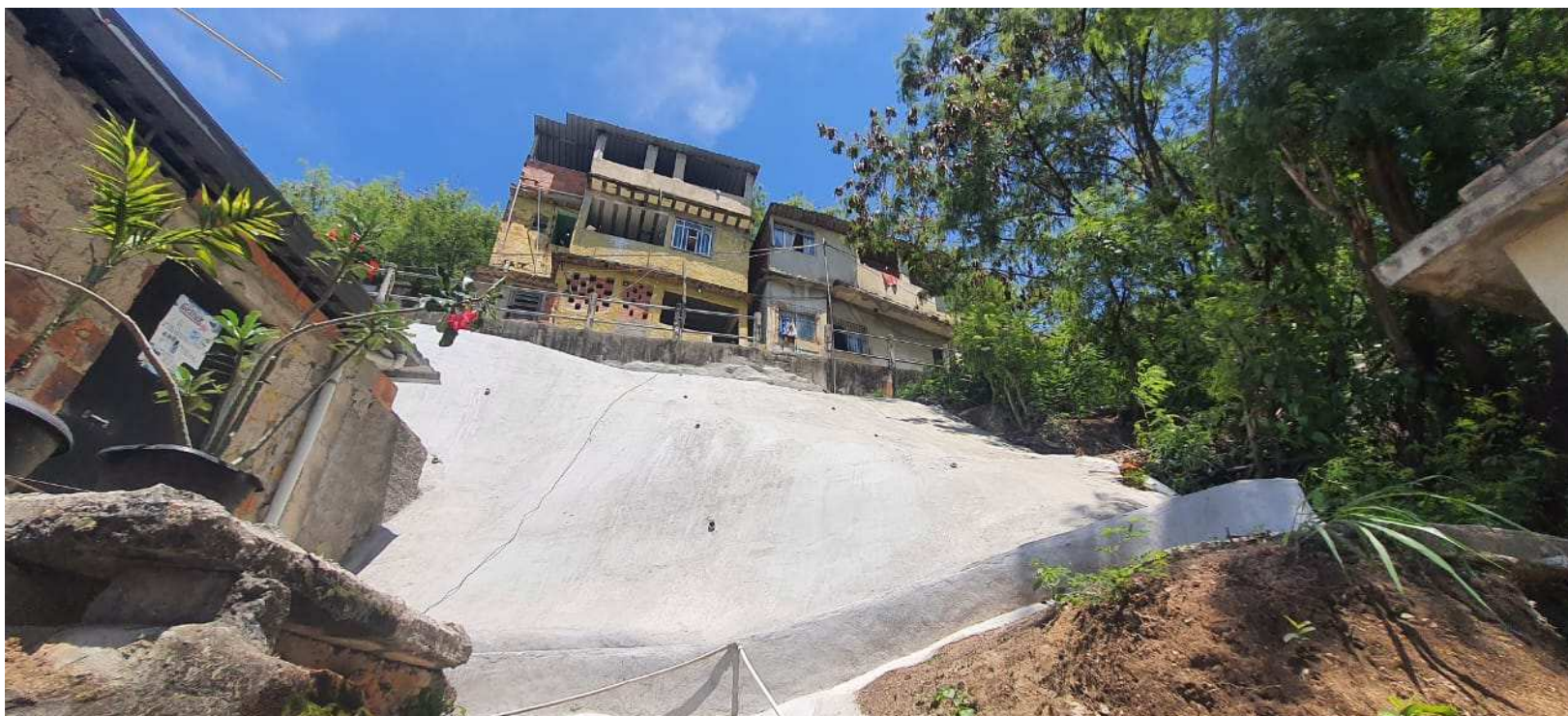
Talude revestido em concreto projetado concluído
