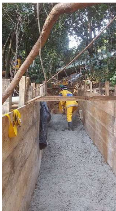
Execução de canaleta de drenagem superficial ao longo do talude
