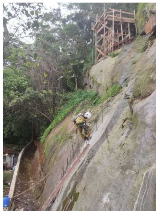
Perfuração dos chumbadores da viga
