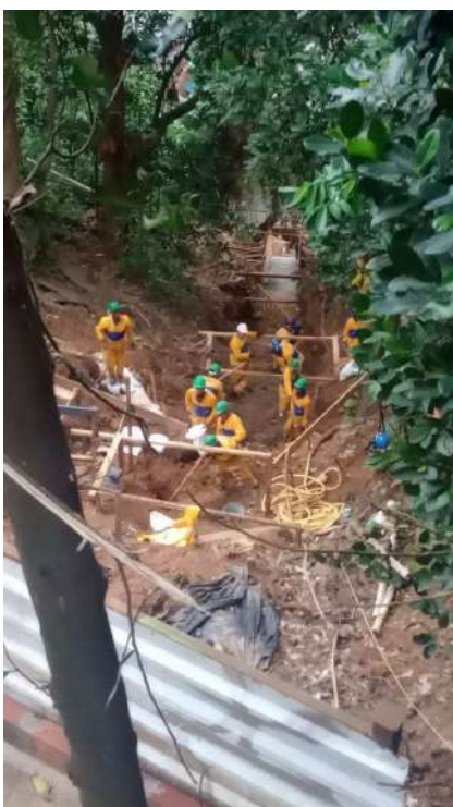
Execução de canaleta de drenagem superficial ao longo do talude
