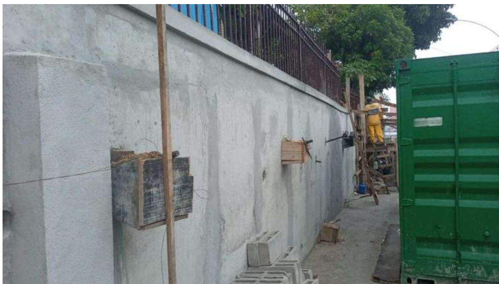
Execução da cortina ancorada e ao lado demolição parcial de muro existente
