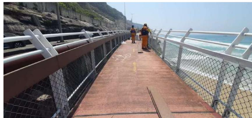
Montagem do guarda-corpo, instalação do cabo de aço e da tela de proteção
