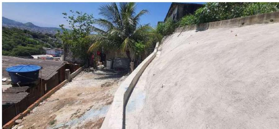
Solo grampeado revestido em concreto projetado e cortina ancorada com guarda-copo
